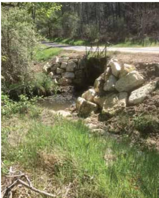
**Le Pont de la Vrignotte**, destabilisé à la suite des fortes précipitations de ces derniers mois, a été consolidé et enoché. Il ne reste plus que les garde-corps à mettre en place.
